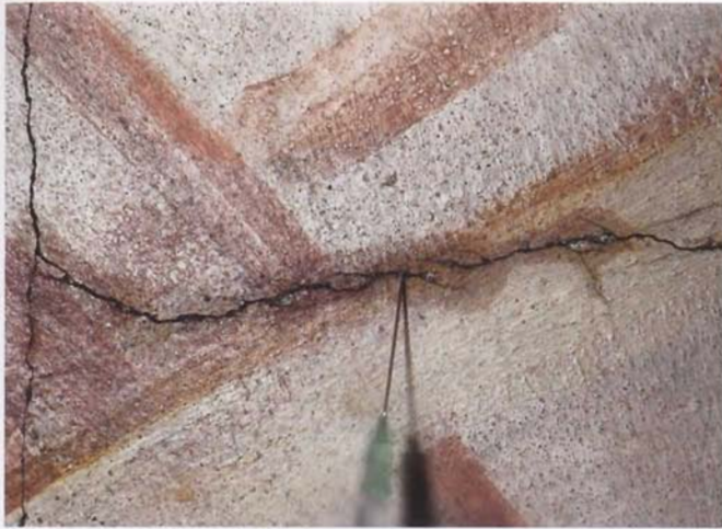
Abb. 123 Putzfestigung von mürben, aufgerissenen Putzpartien. Die Malschichtoberfläche wurde mit einem flüchtigen Bindemittel temporär hydro- phobiert
