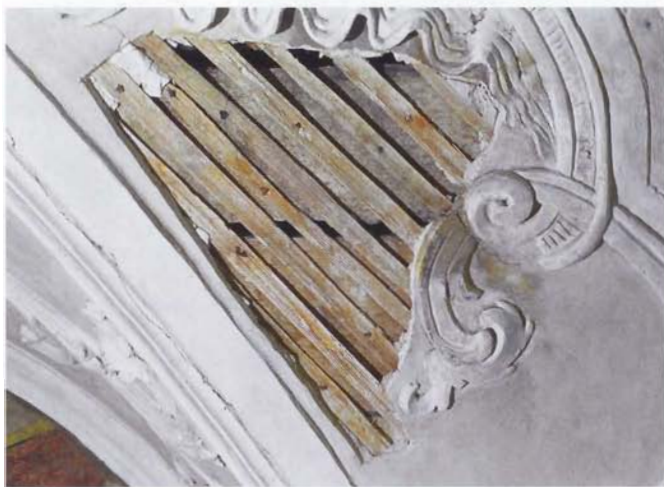
Abb. 118 Putzträgerkonstruktion im Bereich einer Ausbruchsstelle des Stuckes
