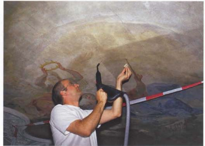
Abb. 124 Arbeitsfoto während der Dampfstrahlreinigung im Mai 2005
